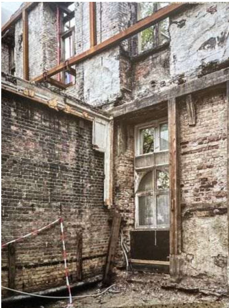
Indersiden af ydermuren viser rester af en stolpevæg til understøttelse af bjælkelaget i etageadskillelsen. Et godt indblik i genopbygningens omfang
