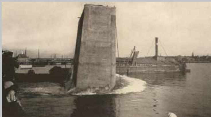
Efter støbning af betonkasser under kontrollerede forhold på lands løbes konstruktionerne af stablen. Teknologi fra skibsbygning anvendes i stort omfang. Havneanlæg med flydende armeret beton caissoner. FRA C&N BROCHURE 1910
