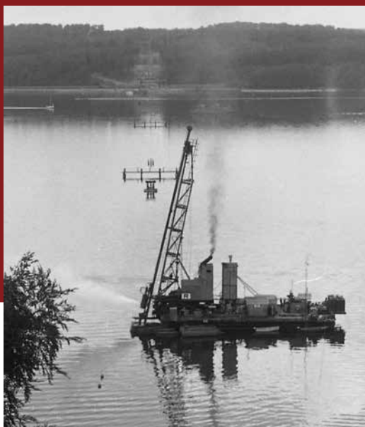
Dampdrevne rambuk i arbejde ved Vejlefjordbroen 1975-1978. Der blev piloteret med pæle på tilsammen 45 kilometers længde. FOTO JAN FRANDBSEN
