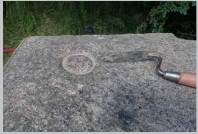
Figur 8: Et fikspunkt indhugget i top af A3 brofacade i vest. Hvornår fikspunktet blev indhugget vides ikke med sikkerhed, men formodentlig skete det i midten af 1800-tallet. FOTO: 2023, BIRGITTE FLØE JENSEN, MUSEUM SYDØSTDANMARK
