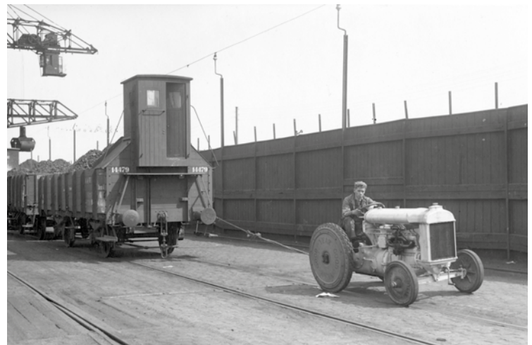
Vogne med kul rangeres med tov af en Fordson vejtraktor på havnen i Aarhus i 1926. Bemærk i øvrigt husene på godsvognene, hvori der skulle sidde en arbejder og bremse, når fløjten lød. Det var nødvendigt, indtil jernbanevognene fik et gennemgående bremsesystem.
