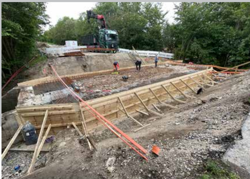
Armeringsarbejderne pågår inden udstøbning med beton foretages.
