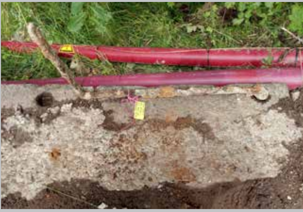
Figur 7: Jernstang, der blev brugt til at samle facadestenen, da man byggede broen i 1786. På fotoet er jernstangen placeret for at vise, at blydelens størrelse passer med hulningerne i en af broens facadesten. FOTO: 2023, BIRGITTE FLØE JENSEN, MUSEUM SYDØSTDANMARK
