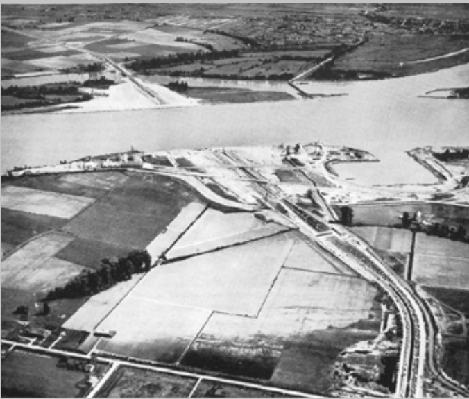
Deas Island Tunnel under anlæg omkring åbningen i 1959. Seks tunnelelementer blev støbt i tørdok ved siden af linjeføringen, sejlet ud og sænket på plads. FOTO C&N
