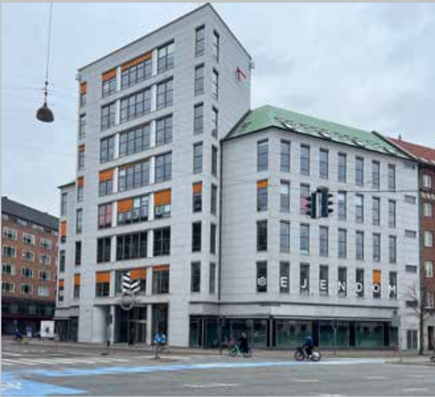
Ørstedhus København, C&N's tidligere hovedsæde opført 1934. Bygget i armeret beton. Huset er en etage højere, end reglerne tillod, grundet længden af brandvæsnet's stiger. Beslutningen viser måske lidt om firmaets tilgang til innovation. FOTO T. OLSEN.
