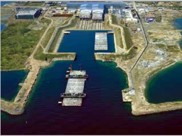
Sænkettunnelelementerne til Øresundstunnelen blev fremstillet på specialbygget fabrik i Københavns Nordhavn. Metoden blev anvendt her første gang. FOTO A/S ØRESUND
