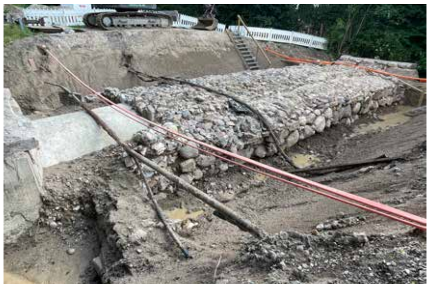
Afgravningen er afsluttet, og oversiden af Cagstrupbro er afrenset ved hjælp af spuling.
