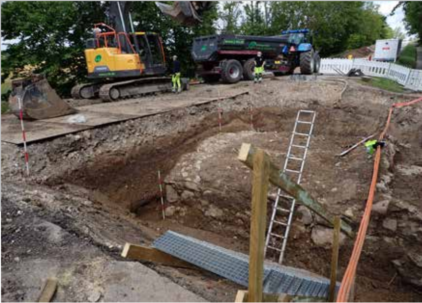
Figur 11 Oversigtsfoto af profil på tværs af buebroen. Til højre er stensætningen, der er ydersiden af broen og over denne i profilen ses lerkappen bestående af flere lag og øverst ses chausséens sten og skærver. Da fotoet blev taget var de overliggende lag af stabilgrus og asfalt fjernet.
