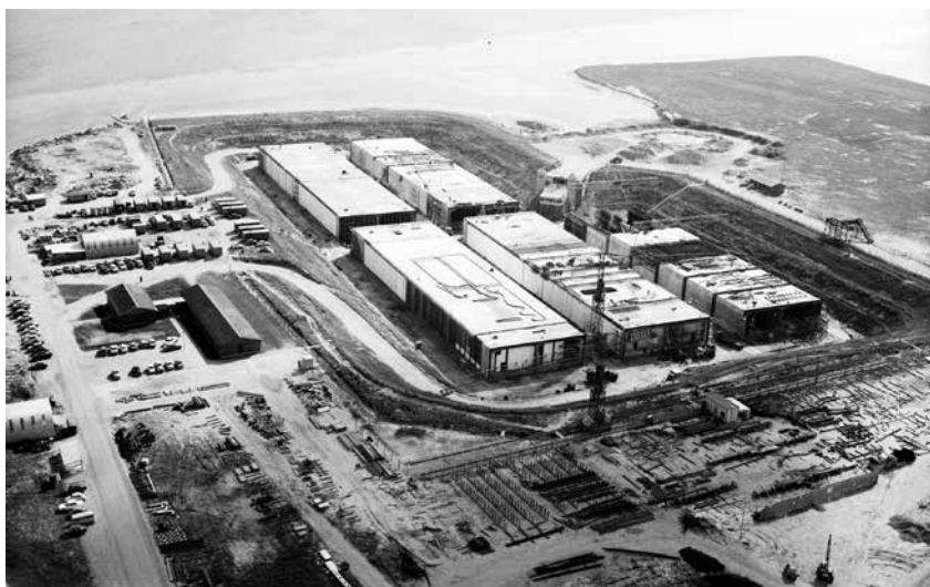
Oversigt af tørdok ved Limfjordstunnelen. Fem tunnelelementer støbtes, bragt til flydning, sejlet og sænket på plads. Tunnelen blev den første undersøiske tunnel i Danmark.
