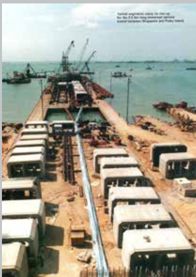
Segmenter støbt på land under fabrikslignende forhold ved Singapore kabeltunnel sikrede byggetid og kvalitet. Segmenter samlet med forspænding. Singapore kabeltunnel åbnede 1988.
