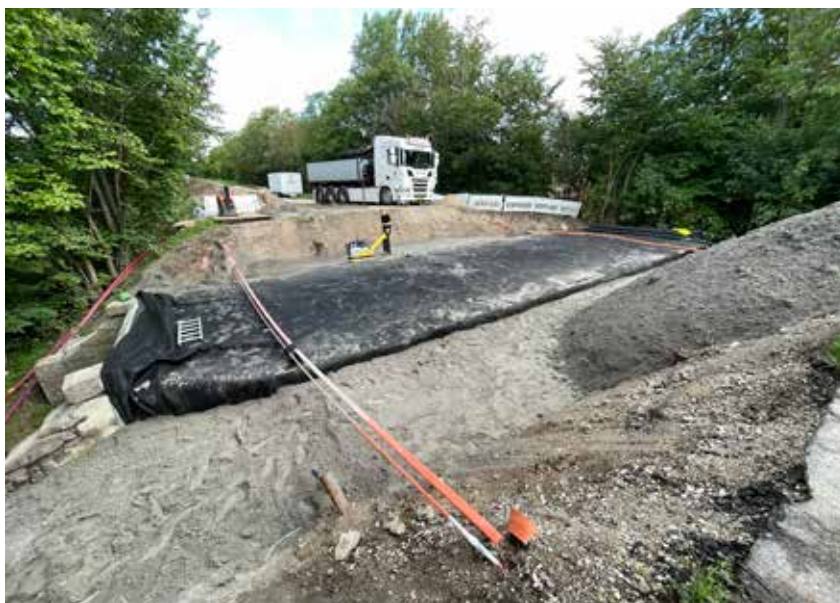
Membran og de beskyttende lag (geotekstil og drænmåtte) er udlagt og genindbygning af vej-kassen er undervejs.
