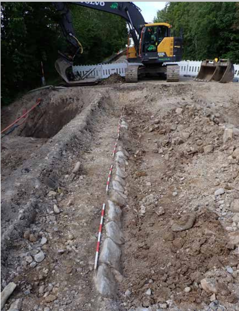
Figur 9: Skråtstillede kantsten sat i chausséens vestside. Selve chausséen og kantstensrækkerne i begge sider var bevaret under asfalten. Chausséen var opbygget af to lag sten nederst, dernæst skærver og øverst grus. Set fra syd.
