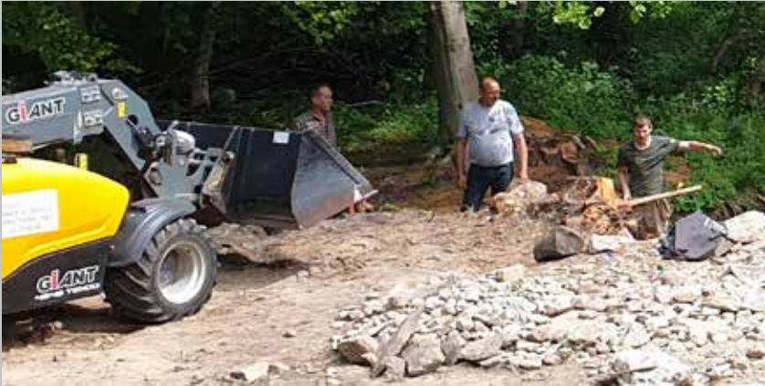
Der måtte lånes entreprenørmaskiner for at bakse de største træer og sten.
