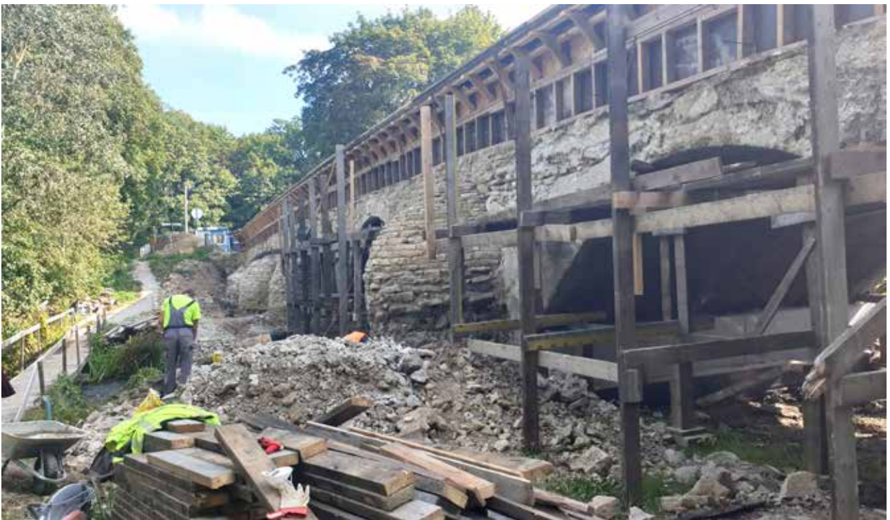
Vanamöisa bro blev oprindelig opført i 1820'erne. Den 64 m lange bro blev opført i limsten med isbrydere foran broen. Renoveringen foregår næsten uden problemer med vand, da floden har mistet det meste af sit vand og i dag kun er en å. FOTO: JØRGEN BURCHARDT.
